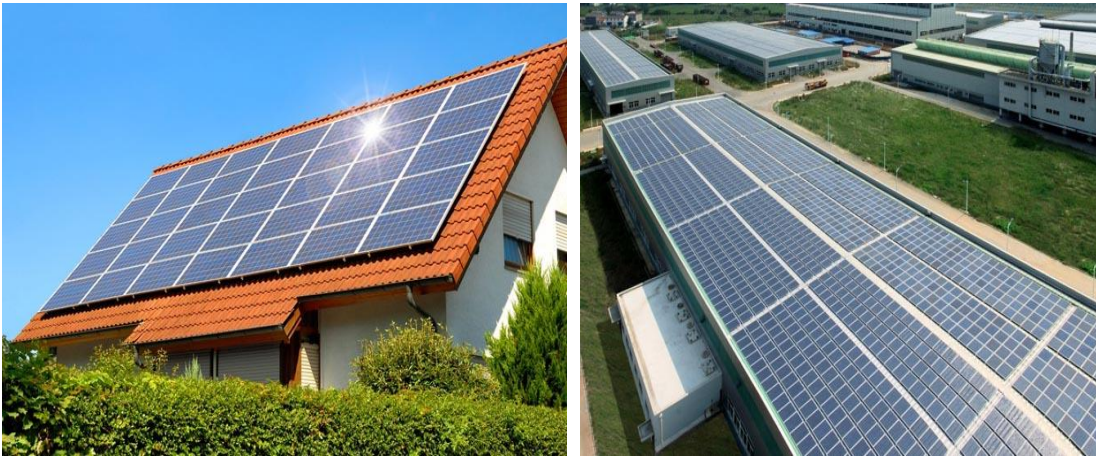
图 16. 安装在屋顶的太阳能电池板
